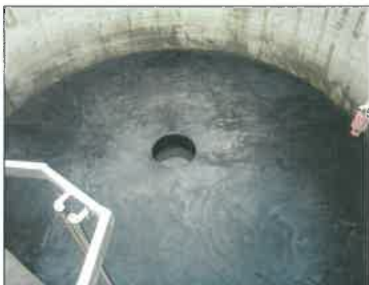
Bassin d'orage après curage
