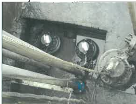
Nettoyage des pompes de vidange
