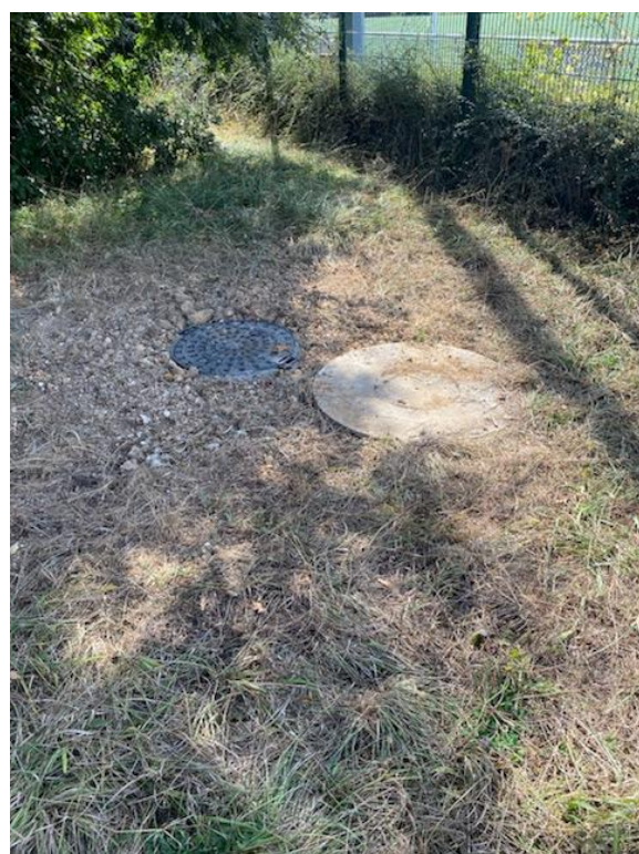
Remplacement d'un tampon sur un ouvrage de type puisard à Marly la Ville
