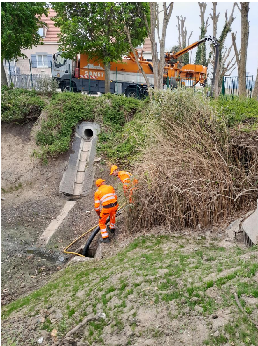
Entreprise SANET lors du curage/pompage de la canalisation de sortie du bassin Impasse des Bergers
