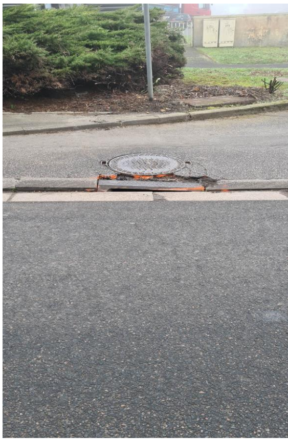
Réhabilitation d'une bouche d'engouffrement à St Witz
