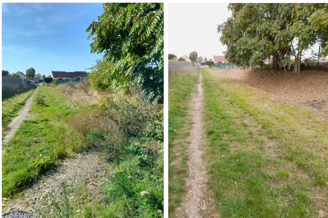
Photo avant/après l'entretien du fossé n°1
