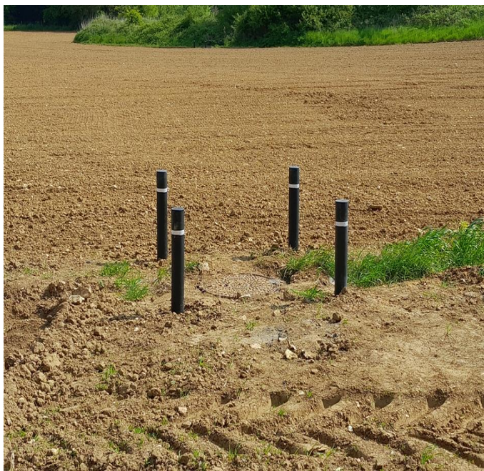
Remplacement d'un tampon et mise en œuvre de potelet
