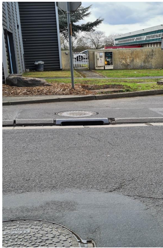
Réhabilitation d'une bouche d'engouffrement à St Witz
