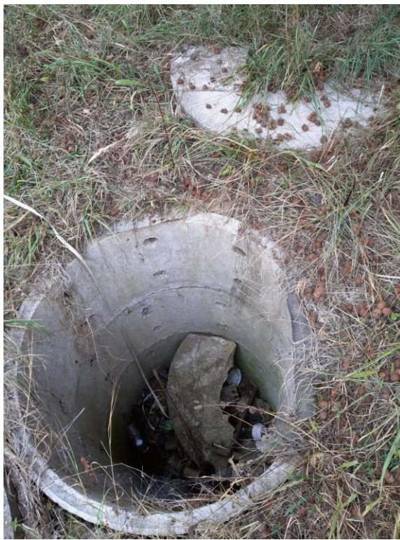
Remplacement d'un tampon sur un ouvrage de type puisard à Marly la Ville
