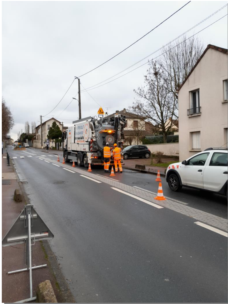
Entreprise SANET : Curage/pompage d'une bouche d'engouffrement 2022
