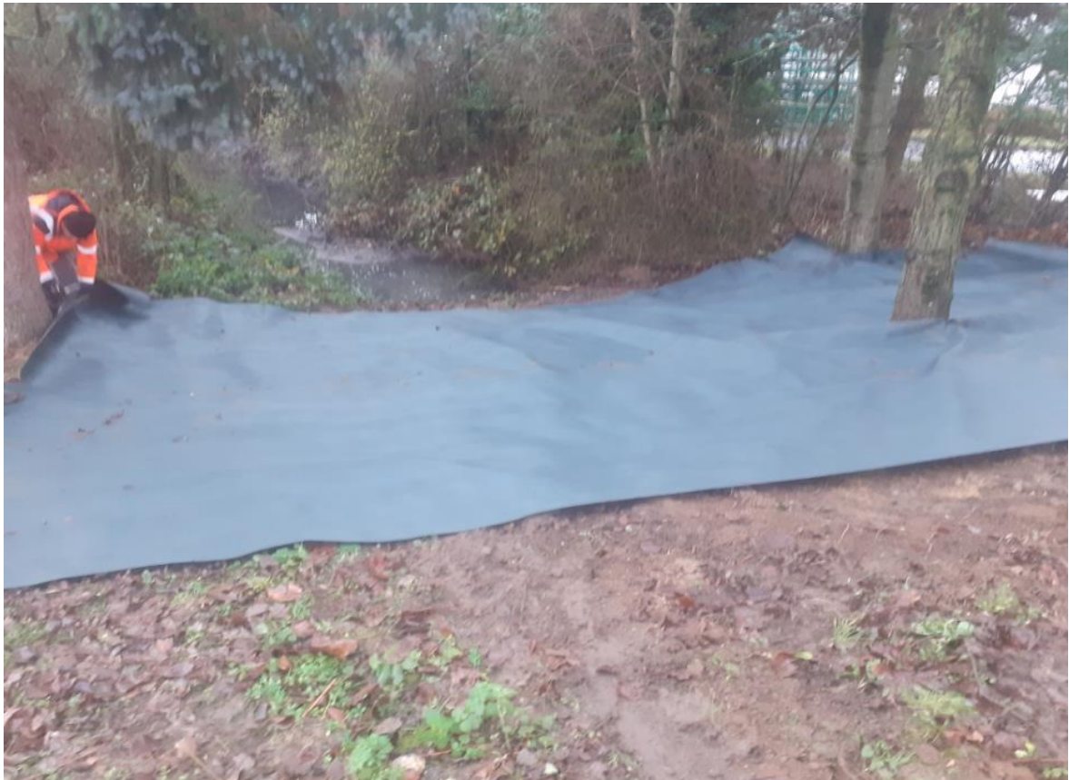
Mise en place d'une bâche plantex black platinum pour le traitement de la renouée du Japon
