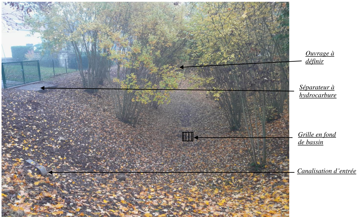
Photos du bassin Epoux Delanchy après nettoyage et entretien des espaces verts
