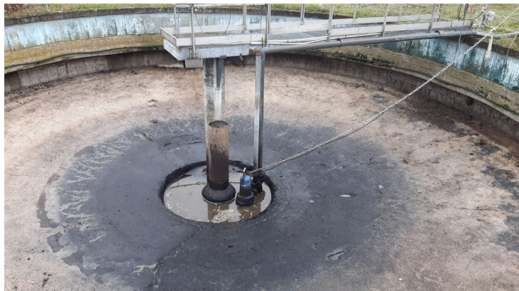
Curage bassin d'orage/clarificateur
