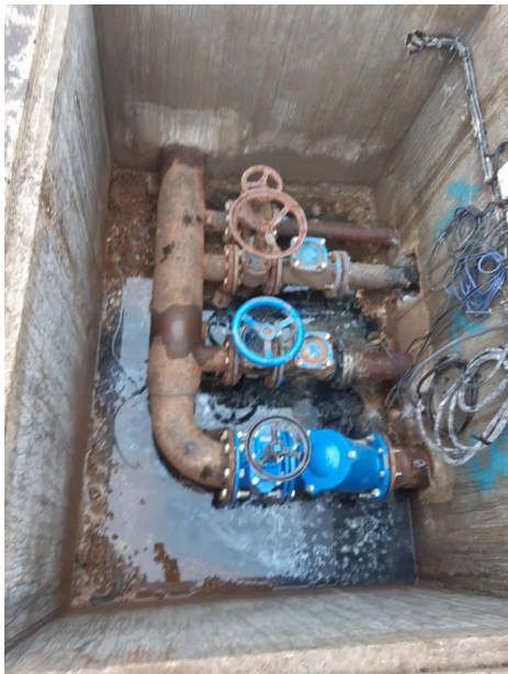
Changement clapet et vanne pompe 3
